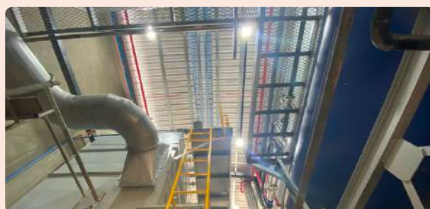
Dự án lò hơi tầng sôi cho ngành giấy KCN Long Giang, Tiền Giang
